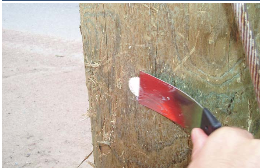
Рис. 8 Выравнивание поверхности
