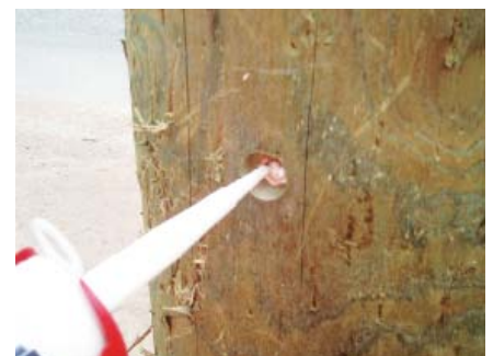
Рис. 5. Внутренняя герметизация отверстия
