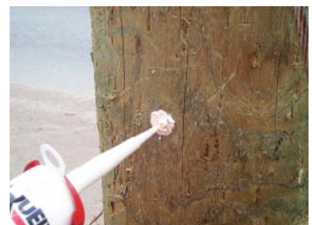
Фото 7. Наружная герметизация отверстия
